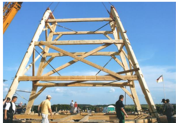
Bild 5: Der erste Teil des Achtkants steht.
