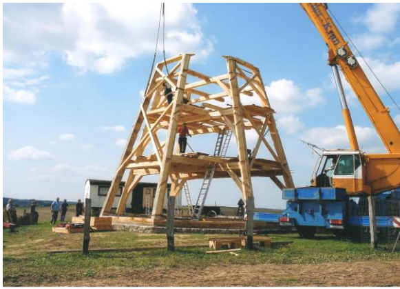
Bild 6: Am nächsten Tag wurden die noch fehlenden Ecksäulen paarweise zusammengebaut, aufgerichtet und montiert.
