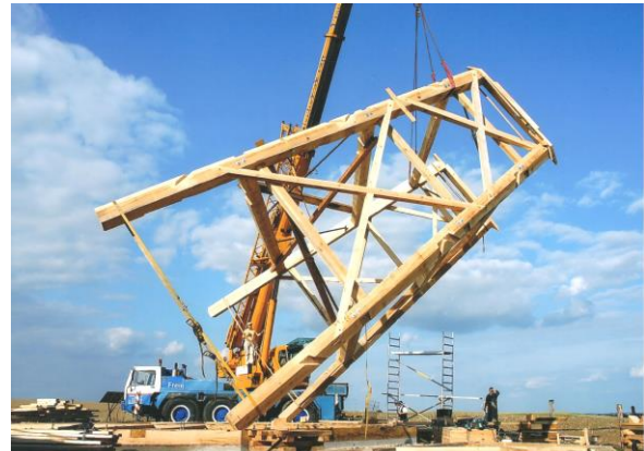
Bild 4: ... und dann angehoben.
