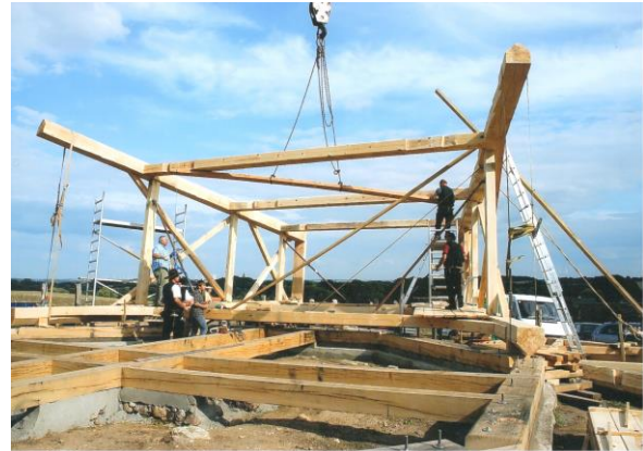
Bild 3: Der erste Teil des Achtkants mit vier Ecksäulen wurde liegend montiert ...
