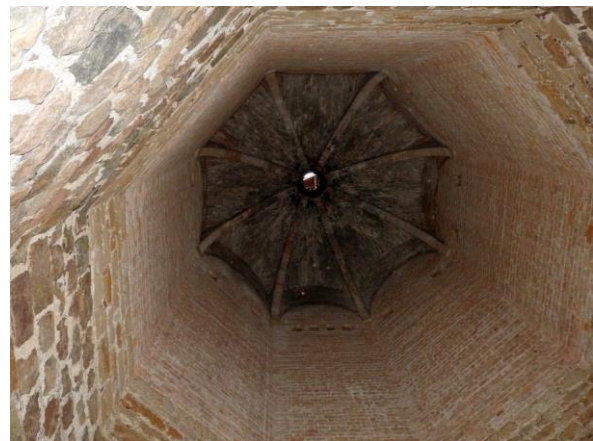
Blick in das sogenannte Angstloch. Der Ringstein bildet den Abschluss des Gewölbes. Das Schutzgeländer ist hier sehr sinnvoll, denn bis zum Boden geht es gut 18 m in die Tiefe.
