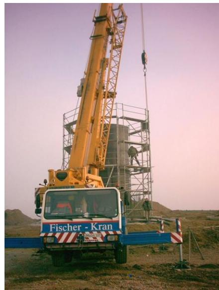
*Bild 2: Aufbau eines Windradfundamentes bei Parstein.*
