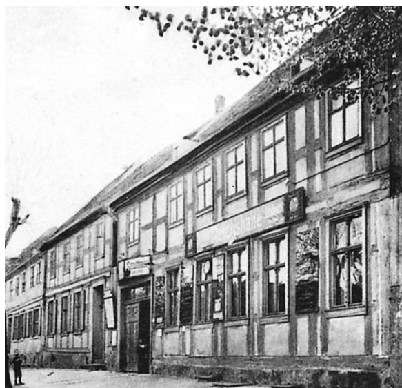
Das Haus Hoher Steinweg Nr. 17. Die Gaststätte trug zuerst den Namen „Zum goldenen Adler“, wurde dann zur „Reichshalle“ und schließlich zum „Haus Uckermark“.
