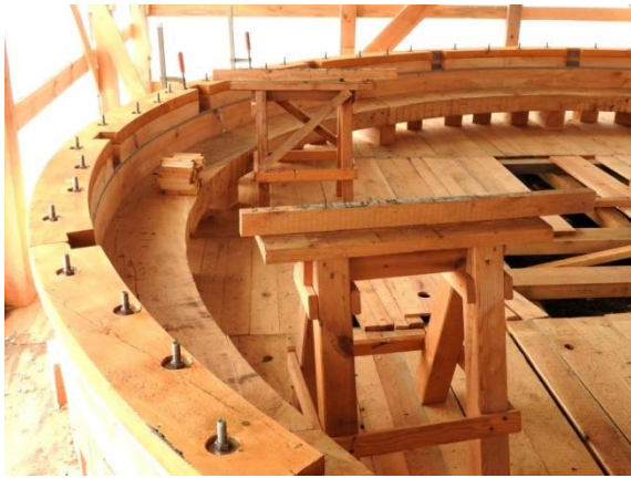
Auf diesem Lagerkranz dreht sich später die Kappe. Die Metall-Laufbahn für die Kugeln des Lagers ist hier noch nicht montiert.
