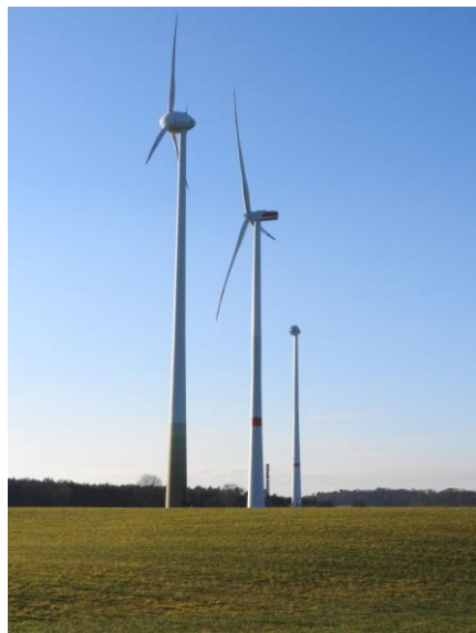
Die Perspektive täuscht: Die E40-Anlage vorn ist nur 122 m hoch, die Senvion-Anlage hat eine Höhe von 200 m und die im Bau befindliche E138 wird mit rund 230 m noch etwas höher.
