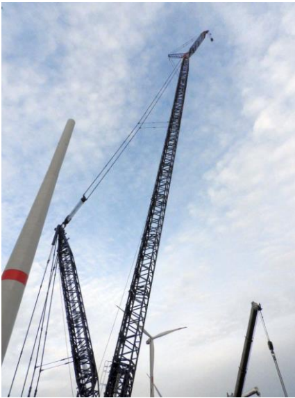
Ein riesiger Liebherr-Kran LR11000 ist notwendig, um das neue Windrad zu errichten.
