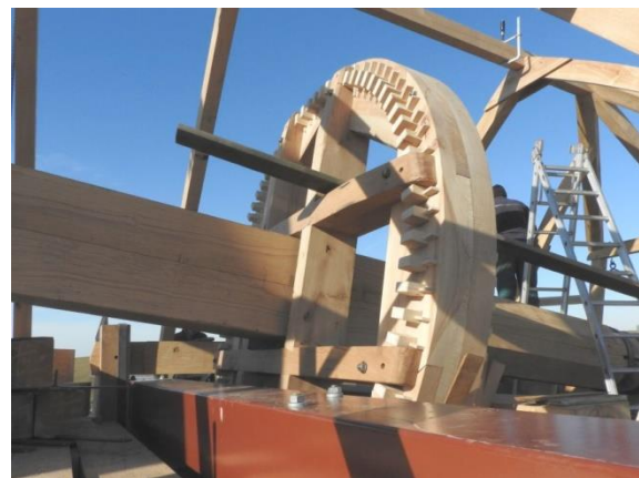
Die Flügelwelle (Rutenwelle) und das große Kammrad sind hier schon eingebaut.
