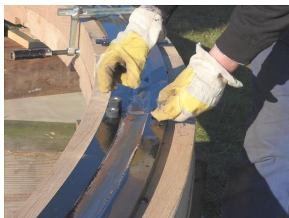
die vom PCK gefertigten Laufbahnelemente aus Stahl aufgeschraubt werden können.
