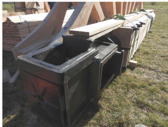
An der Vorderseite der Flügelwelle ist der gußeiserne Wellkopf angebracht. Am Wellkopf werden später die Flügel befestigt. Dieser Wellkopf wurde im Jahr 1867 von der Firma A. Grothe hergestellt und stammt von einer ehemaligen Bockwindmühle aus Wittstock. Für den neuen Einsatz wurde er mit verschweißten Stahlbändern verstärkt.
